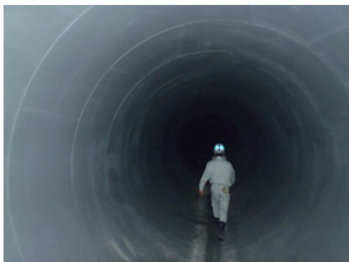
近年増加する地下構造物
